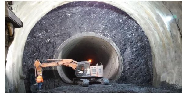
DEMOLIZIONE CONCI TBM
