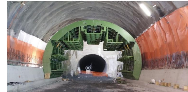
GETTO RIVESTIMENTO DI CALOTTA
