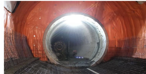
POSA ARMATURE ARCO ROVESCIO E MURETTE
