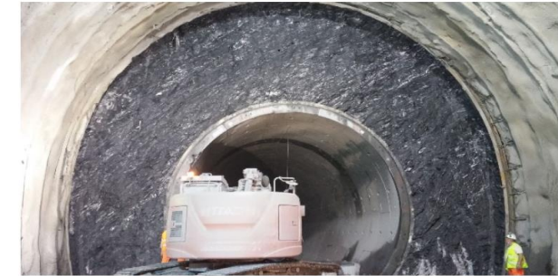
SCAVO IN ALLARGO
